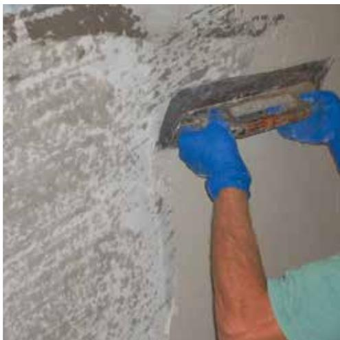
La impermeabilización es un reto permanente. LATICRETE® ofrece impermeabilizantes muy eficaces que sellan y protegen suelos y paredes para aplicaciones ocasionalmente húmedas, como baños, balcones o terrazas, o continuamente sumergidas, como duchas o piscinas.
